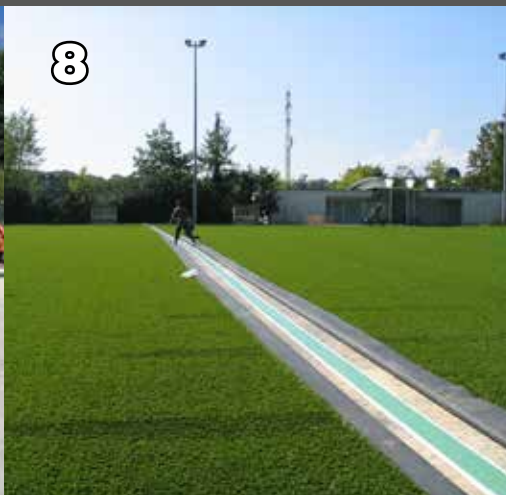
8 Les tapis sont posés côte à côte et collés avec une précision millimétrique.
