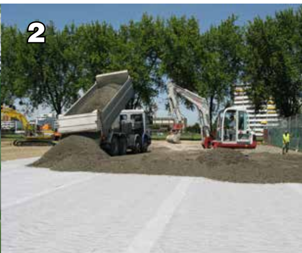
2 Mise en place d'un coffre de fondation permettant de transmettre les charges au sous-sol sans déformation.
