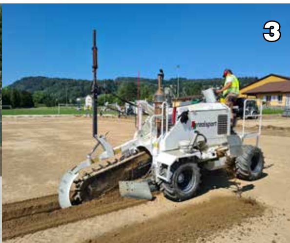
3 Le système de drainage sera étudié pour permettre d'évacuer les eaux de surface rapidement vers l'exutoire, le terrain est ainsi jouable par tous les temps.
