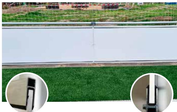
Illustration du rail supérieur avec joint en caoutchouc
