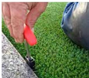
L'élément de fixation est inséré dans l'élément de montage à l'aide d'une clé de montage, jusqu'à la nervure inférieure (voir les photos des pages précédentes).
