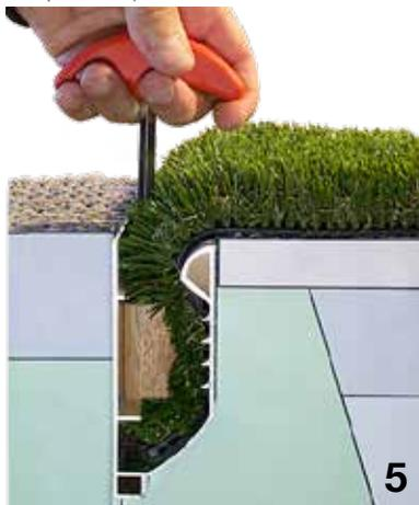
Après l'introduction jusqu'à la barre d'arrêt, l'élément est tourné de 90°. Ensuite, la clé d'insertion est soulevée. La fixation réalisée tous les 50 cm env. garantit que le gazon synthétique résistera aux forces de traction.
