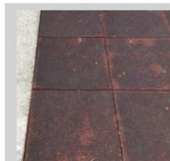
**Les dalles souples préfabriquées** sont bien souvent composées de granulats de pneus noirs liés au moyen de polyuréthane teinté. Rapidement, la pellicule de peinture s'use laissant apparaître les grains de pneus alors en contact avec les utilisateurs, ce type de contact n'est pas conseillé.
