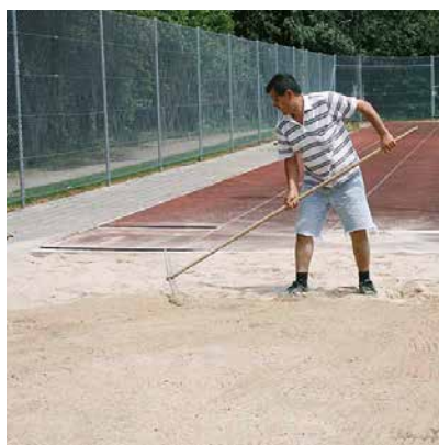
Travaux de finition
