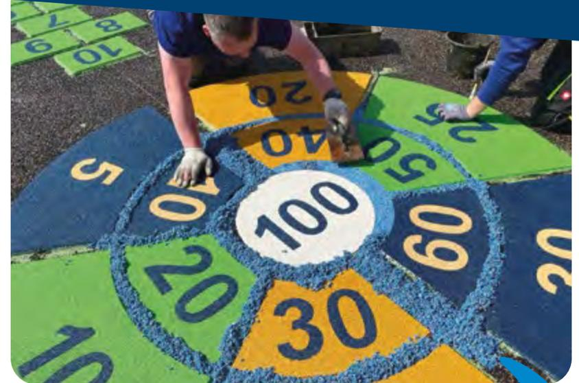
Forme spéciale, pas de découpage, avec bordures obliques de 45°, qui permettent une parfaite surface en EPDM pour sol souple autour des graphiques, ainsi que des joints stables et durables.
