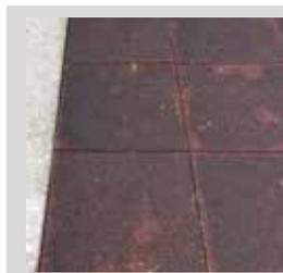
**Die elastischen**, vorgefertigten Bodenplatten sind in Verbindung mit schwarzen Pneugranulat, mittels gefärbten Polyurethans.
