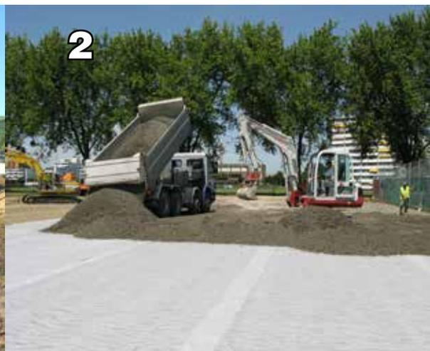
Mise en place d'un coffre de fondation permettant de transmettre les charges au sous-sol sans déformation.
