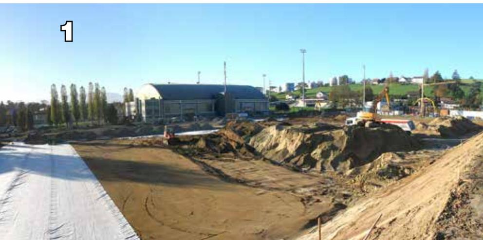
La première phase dans la réalisation d'un terrain de foot en gazon artificiel est de créer une plate-forme dont les caractéristiques de planéité, de portance et de stabilité dans le temps sont compatibles avec une telle réalisation. En effet, la moindre déformation du sous-sol sera visible en surface et peut dans certains cas mettre en cause l'utilisation même du terrain.
