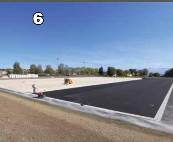
Réalisation de la couche de souplesse coulée ou préfabriquée, nécessaire pour certains systèmes Realsport.
