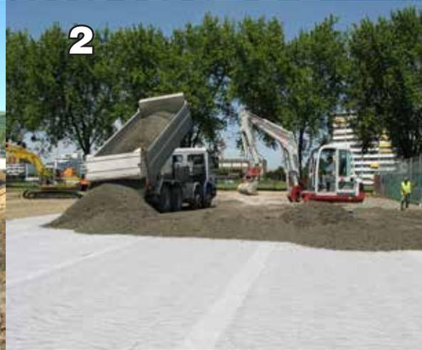
Eine entsprechende Koffersohle sorgt für eine Übertragung der Bodenbelastung ohne Deformation.
