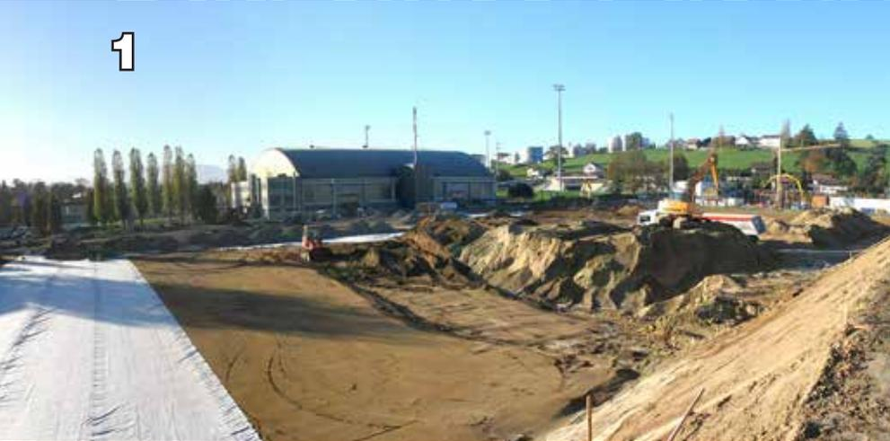
In der ersten Phase der Realisierung eines Fussballfeldes mit Kunstrasen gilt es eine Planie zu schaffen, deren Eigenschaften in Bezug auf Ebenheit, Tragfähigkeit und Stabilität auf lange Sicht geeignet sind. Jede kleinste Verformung des Untergrunds überträgt sich auf die Oberfläche und kann in manchen Fällen sogar die Nutzung der Spielfläche beeinträchtigen.
