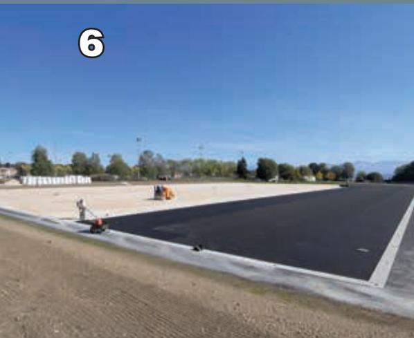
Verlegung der gegossenen oder vorgefertigten, elastischen Schicht, die für bestimmte RealSport-Systeme notwendig ist.
