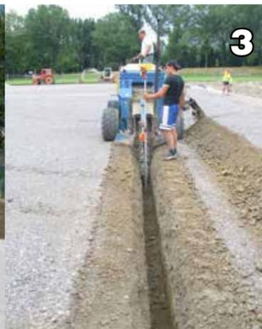
Ein Drainagesystem wird konzipiert, um das Oberflächenwasser zügig abfliessen zu lassen und damit das Feld bei jeder Wetterbedingung beispielbar zu halten.
