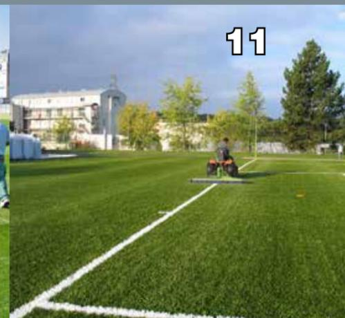
Bürsten des Kunstrasens während der Bauphase. Durch mehrfaches Bürsten nach genau vordefiniertem Muster werden die Füllmaterialien ebenmässig und mit gleichbleibender Dicke verteilt.
