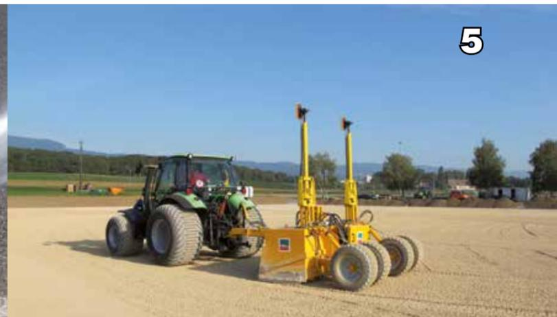
Planierung der Tragschicht, auf welcher später der Kunstrasen verlegt wird. Diese kann aus einem durchlässigen bituminösen Mischgut oder aus Kies bestehen, deren Eigenschaft für eine Stabilität und gleichzeitige Durchlässigkeit sorgt, die für eine einwandfreie Nutzbarkeit der Oberfläche unerlässlich ist.
