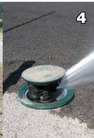
Test des Bewässerungssystems vor der Verlegung der Tragschicht. Die Bewässerung ermöglicht die Steuerung der Temperatur des Belags während grosser Hitze.
