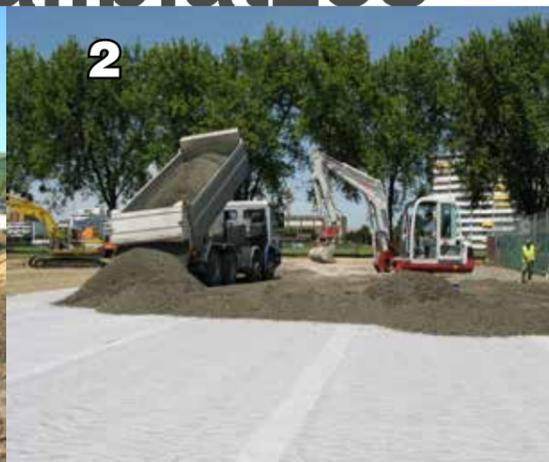
Eine entsprechende Koffersohle sorgt für eine Übertragung der Bodenbelastung ohne Deformation.
