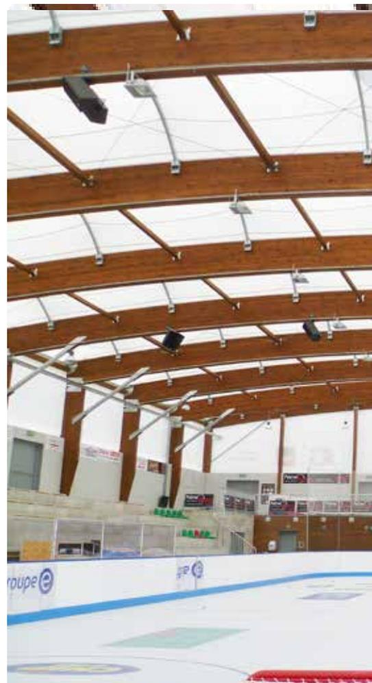
cassettes rayonnantes à gaz offrent une flexibilité étonnante. Elles fonctionnent uniquement lorsque le sportif est en action. 3 minutes après avoir appuyé sur un bouton, la surface est tempérée, l'inertie est très faible. Fini les interminables délais de préchauffage. Une température de 12 degrés est idéale pour la pratique sportive.
