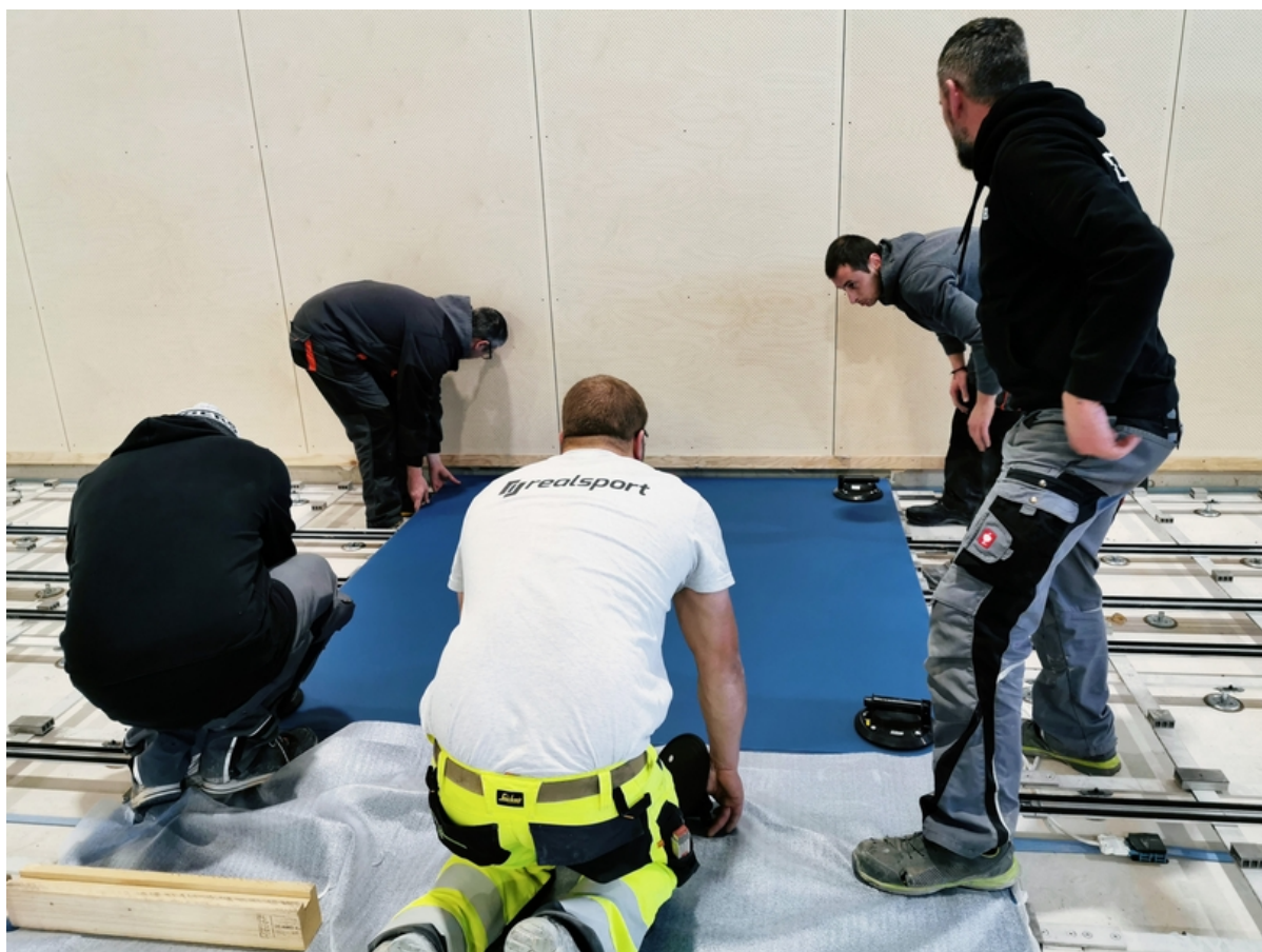
Pose et ajustage des panneaux de verre à l'aide de ventouses.
