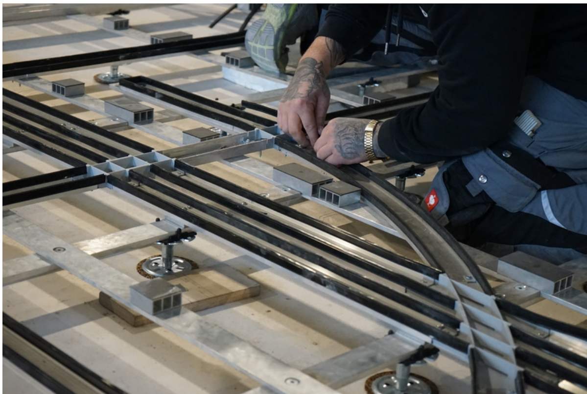
Construction de la sous-structure souple métallique et des canaux pour les marquages en LED.
