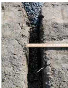
Le tube de drainage posé, la tranchée est remplie de gravier lavé afin de garantir une circulation de l'eau durant de très nombreuses années.
