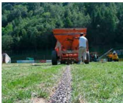
Création d'un réseau de fentes de suintement sur un terrain existant au moyen de trancheuses et de silos de remplissage développés par RealSport.
