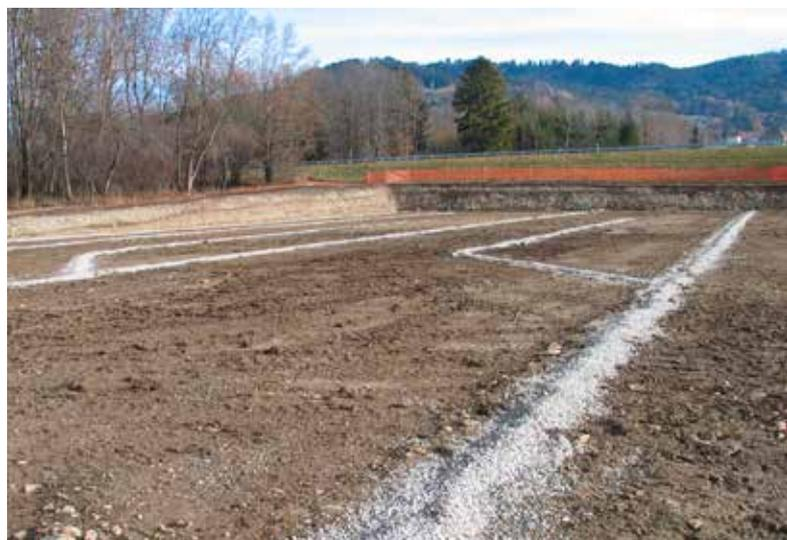
Le tube de drainage posé, la tranchée est remplie de gravier lavé afin de garantir une circulation de l'eau durant de très nombreuses années.
