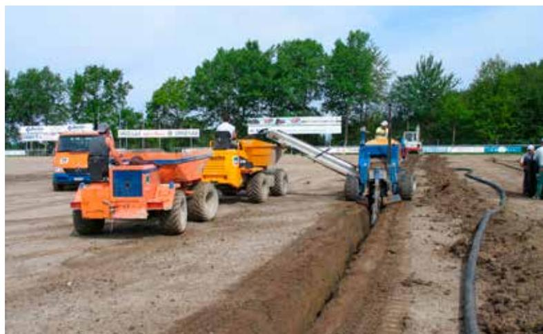
Le système de drainage principal est tranché dans le sol en place, avant la mise en place de la couche de support.
