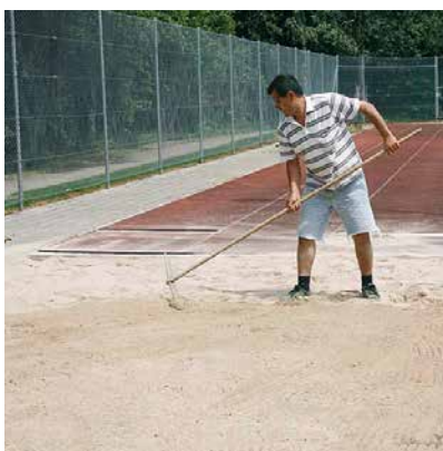
Travaux de finition
