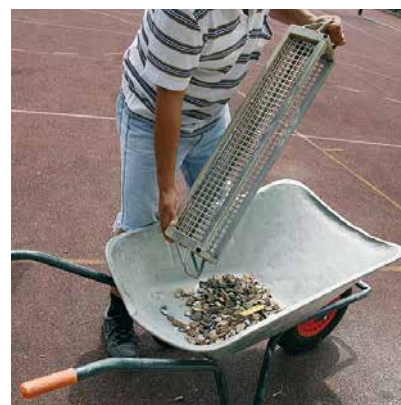
Evacuation des déchets
