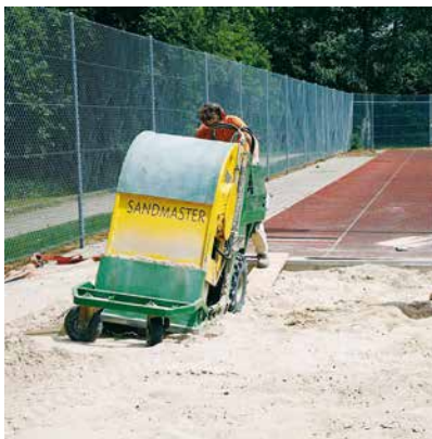
L'entrée dans l'installation
